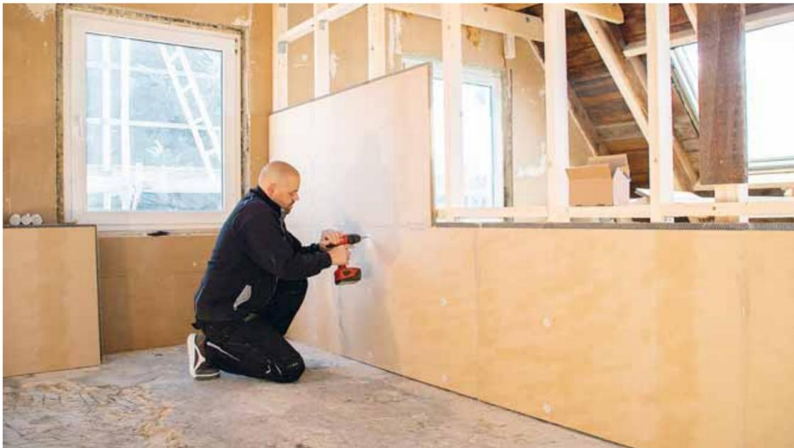
Befestigung der Dämmplatte auf allen tragfähigen Untergründen
